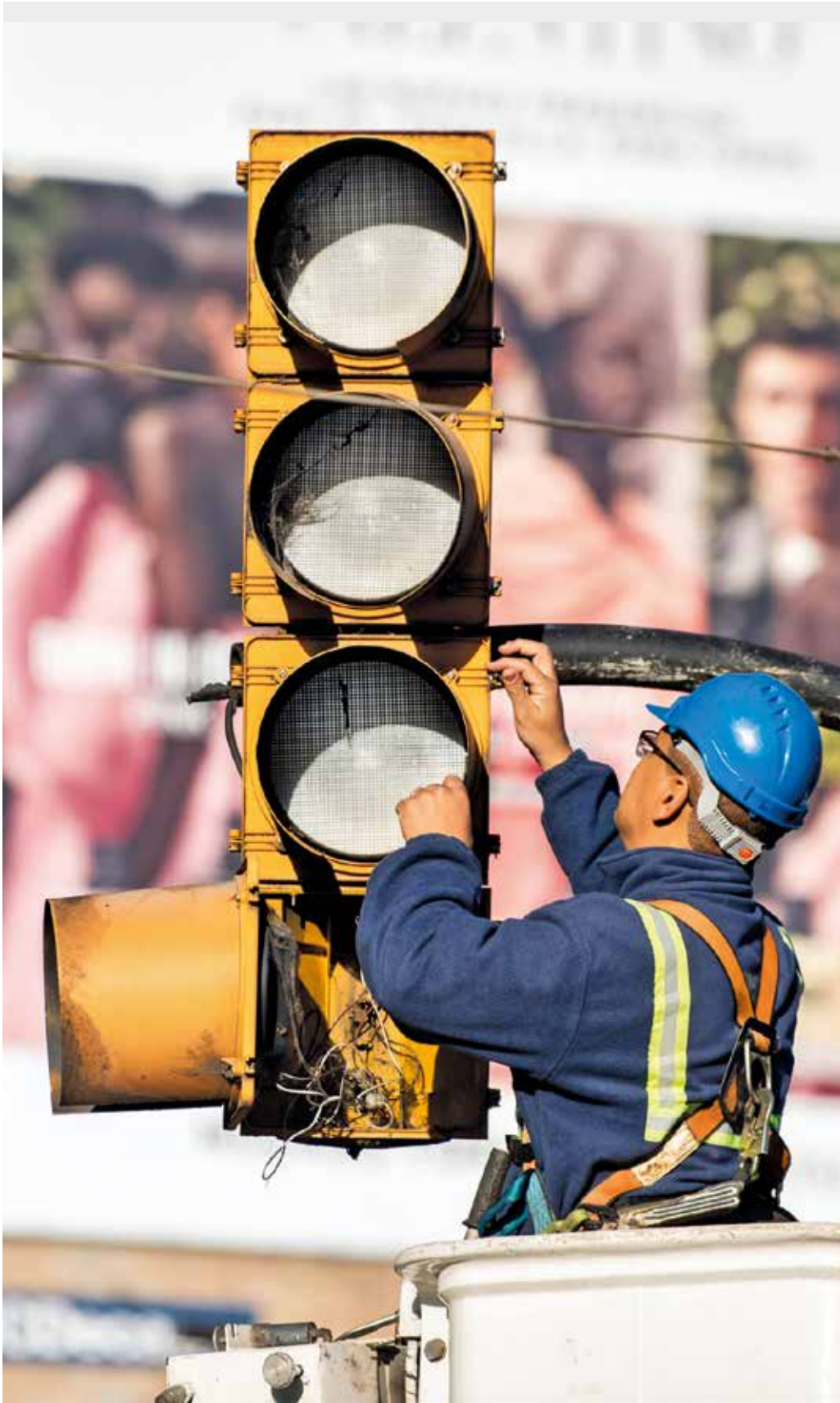
Montevideo se adelanta: obras de tránsito adaptativo. Foto: Santiago Mazzarovich/ IM.
